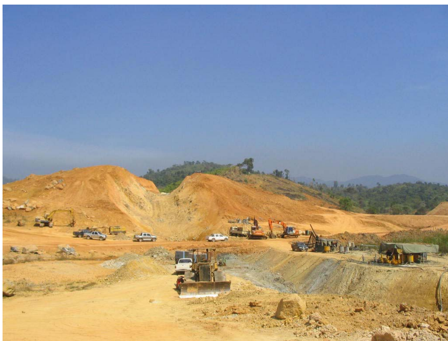
รูปที่ 9-2 แสดงการขุดลอกหน้าดินและขุดร่องแกน
