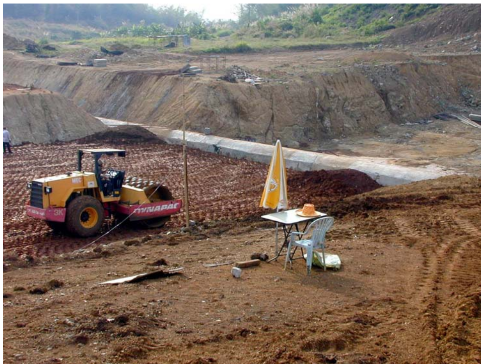
รูปที่ 9-8 แสดงการบดอัดดินตัวเขื่อน
